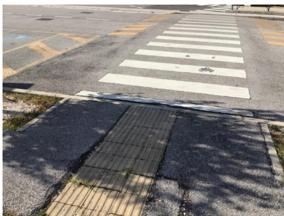
Palamaser/Via Motte – segnaletica tattile di orientamento posta in maniera impropria (mancanza di bolloni "pericolo valicabile" e larghezza eccessiva)
