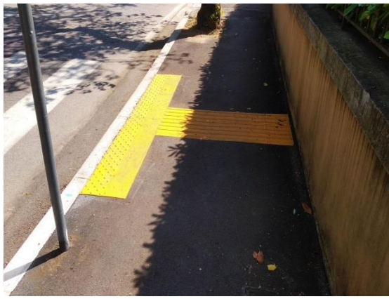
Via Maffei (VI) – esempio di segnaletica tattile di orientamento posta in maniera adeguata
